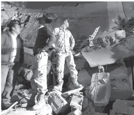
Թրիպոլիի մէջ, Քատաֆիի յենակէտերէն մէկը, դաշնակից օդանաւերու ուժակոծումէն վերջ
